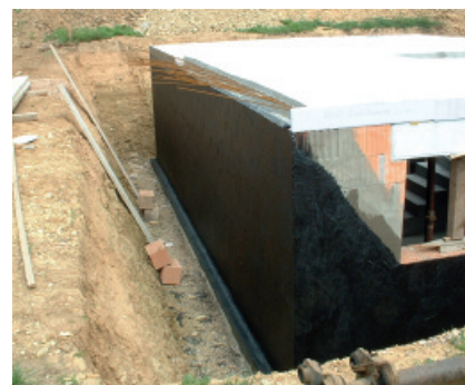
Uszczelnienie zewnętrznej ściany piwnicy z betonu przy zastosowaniu PCI Pecimor® 2K. Wygodna obróbka dzięki wypełnieniu polistyrenowemu.
