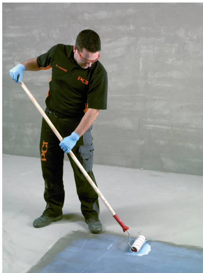
PCI Gisogrund® dobrze nadaje się do gruntowania pod wylewki poziomujące.
