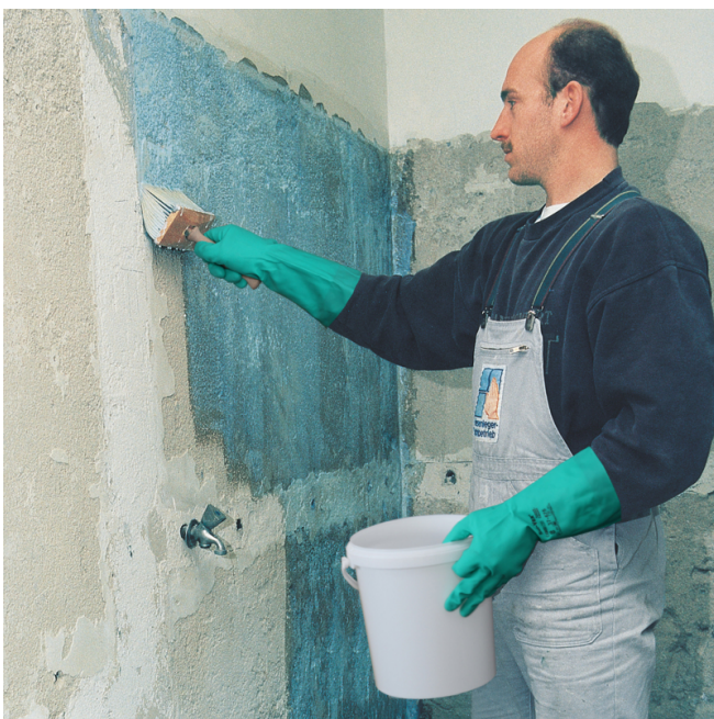
PCI Gisogrund® poprawia wytrzymałość i nośność starych, osypujących się tynków, podwyższa przyczepność płytek, tynków, zapraw i tapet.
