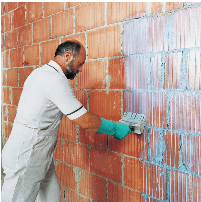
PCI Gisogrund® poprawia przyczepność tynków gipsowych i wapienno-gipsowych do murów z cegły.
