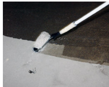
PCI Epoxigrund 390 można aplikować wałkiem lub pędzlem.
