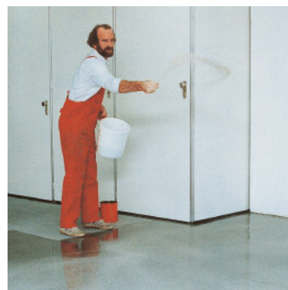
Posypka piaskiem kwarcowym PCI Quarzsand 0,3 - 0,8.
