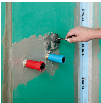
Przed nałożeniem kołnierza hydroizolacyjnego PCI Pecitape 10 x 10 należy nałożyć odpowiednią ilość materiału hydroizolacyjnego również wokół przewodów wodociągowych.
