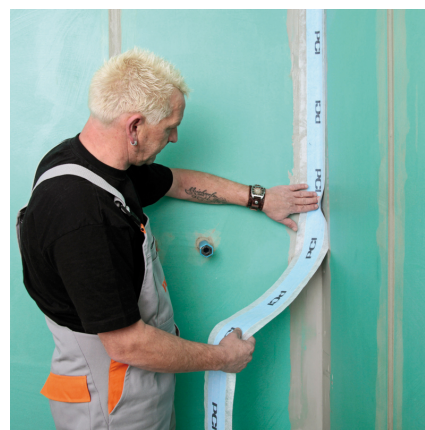
Wyrównać taśmę hydroizolacyjną PCI Pecitape ręcznie i lekko docisnąć.
