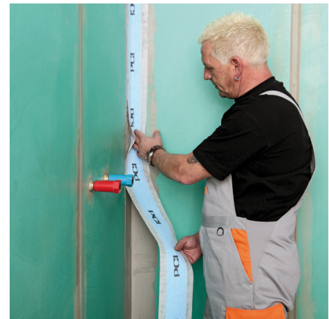
Taśmy PCI Pecitape są wtapiane w świeżą warstwę stosowanego materiału hydroizolacyjnego.
