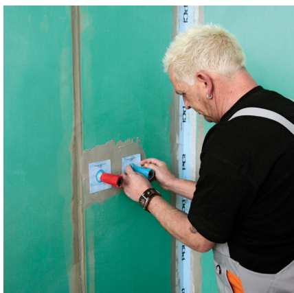
Następnie ostrożnie nałożyć kołnierz uszczelniający
