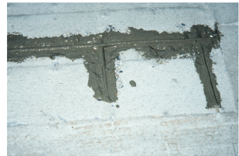
Zabezpieczenie antykorozyjne stali zbrojeniowej za pomocą PCI Nanocrete ® AP. W celu zapewnienia całkowitego pokrycia zbrojenia, zaprawę można nanosić także na przylegające podłoże.
