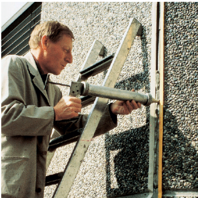
Uszczelnienie szczeliny dylatacyjnej między płytami elewacyjnymi z fakturą betonu zmywanego.
