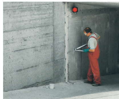
PCI Apogel ® PU pozwala na szybkie uszczelnienie rys wypełnionych wodą.
